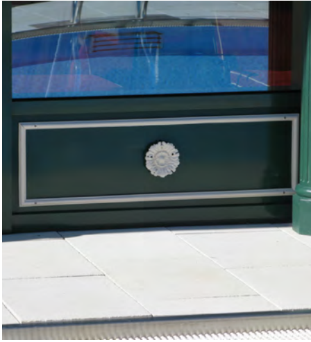
Wintergarten: Zierrahmen profiliert und Zierrosette aus Aluminiumguss.
