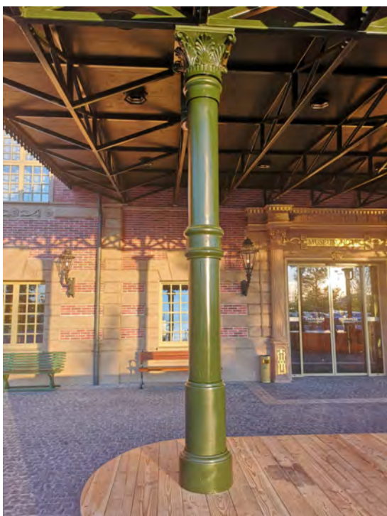
Vordach: Sonderanfertigung von Rohraufschubteilen für Säulen mit Rohr DM 200 mm.
