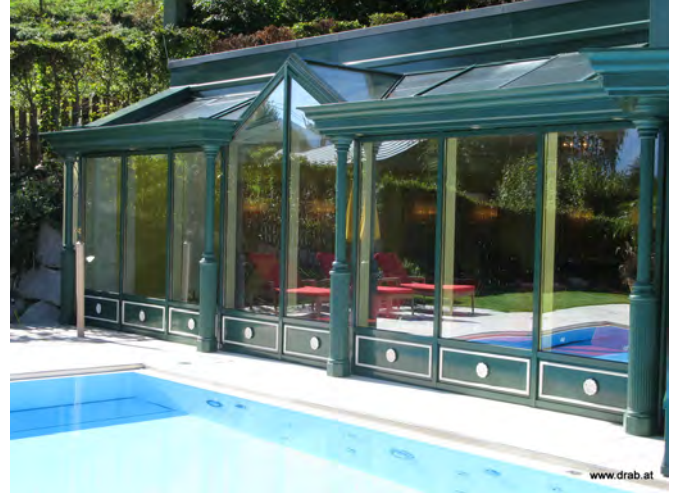
Wintergarten: Dachgesimse profiliert und Stützsäulen aus Aluminiumguss.
