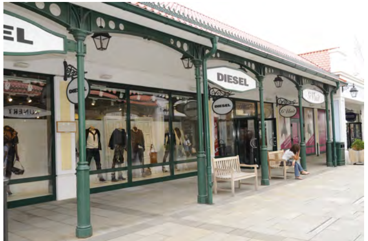
Überdachung: Eisenkonstruktion, Säulen Stahlrohr DM 101 mm mit Säulenteile "Parndorf" aus Gusseisen, Schneerechen am Dach aus Aluminiumguss.
